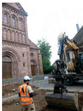
Travaux pour la requalification de la place de l'église – Gueberschwihr
