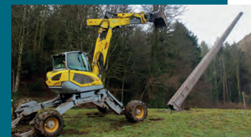
Dépose de poteaux électriques à Mittlach ©TEA
