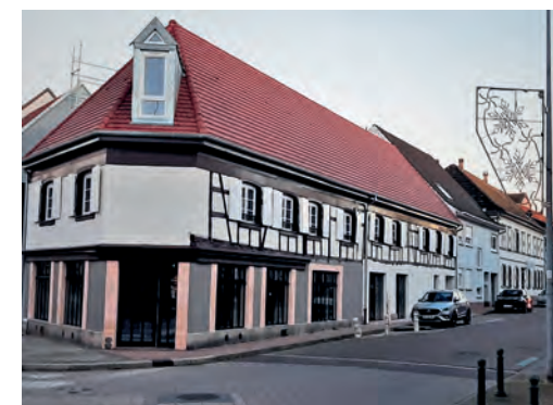
Réhabilitation de l'espace Charrons/Pharmaciens à Bischwiller. Ancienne maison alsacienne du 17 ème siècle remise à neuf avec une partie contemporaine au rez-de-chaussée et 5 logements à l'étage. (© Alsace Habitat)
