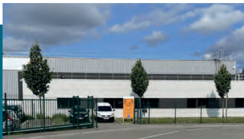
Entrepôt de distribution
